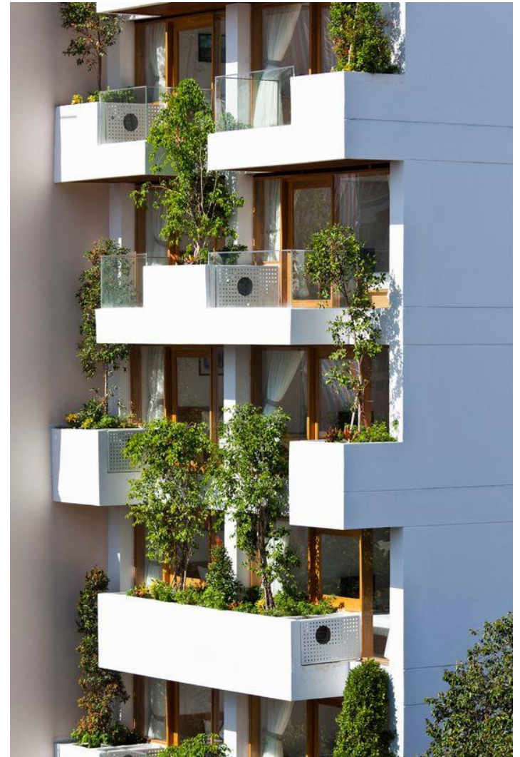
Beispiel intensive Fassadenbegrünung
