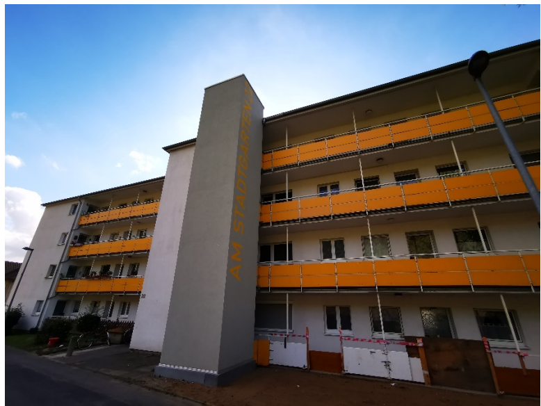
Sanierung „Am Stadtgarten 22“
