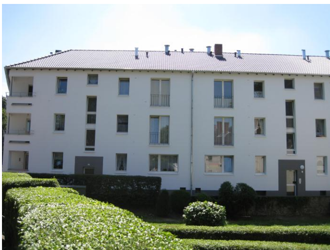
Wärmedämmung Am Stadtgarten 8 – 12
