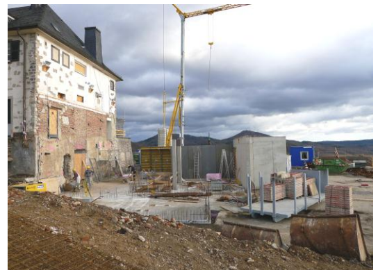
Hochbauarbeiten am Drachenfels
