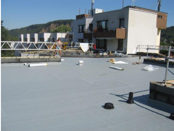
Sanierung Dach Wohnpark Nord
