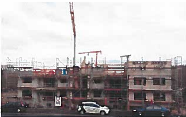
Neubau Herresbacher Straße 30
